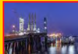
LNG terminal commissioned in Hazira.
